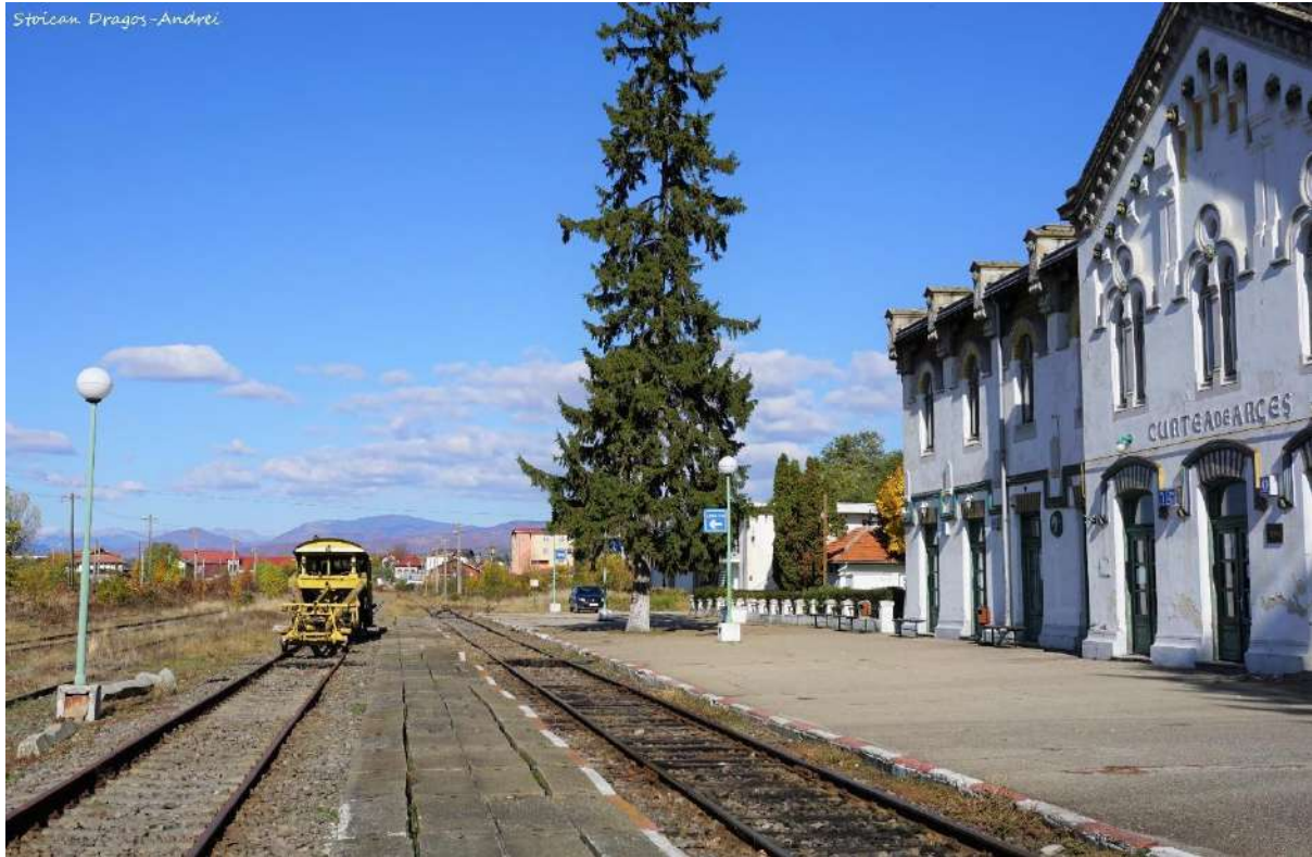
Figura 26 – Peroanele din gara Curtea de Argeș
