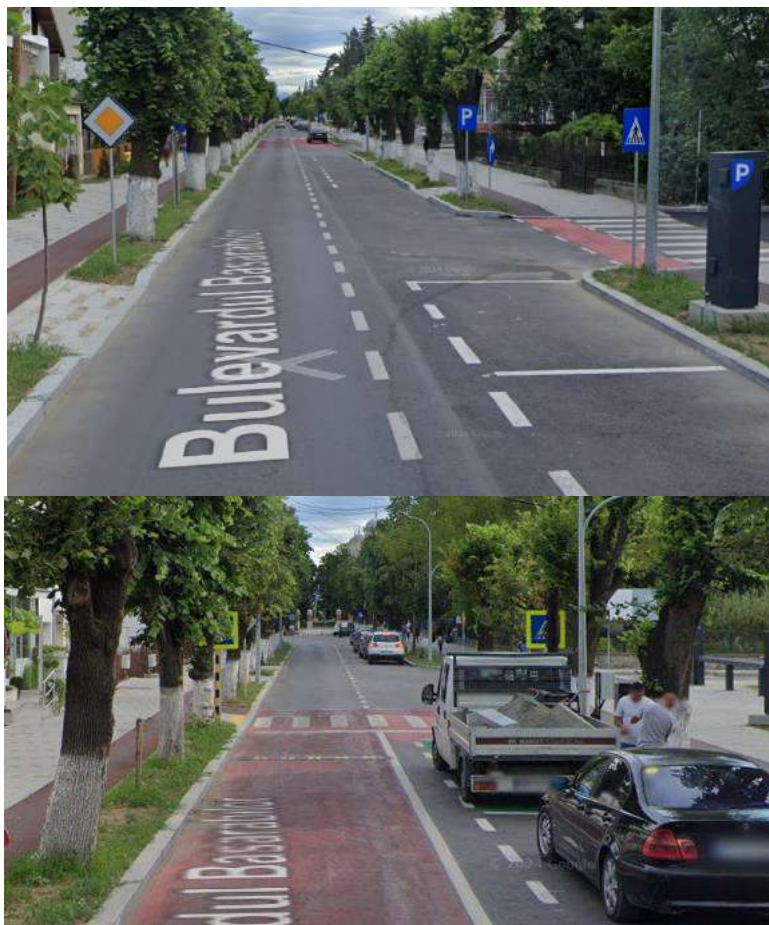
Figura 28 – Parcare amenajată pe Bd. Basarabilor care nu respectă codul rutier și nu asigură condiții minime de vizibilitate. Sursa : googlemaps.com
